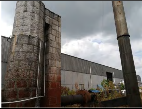
锅炉处理设施
